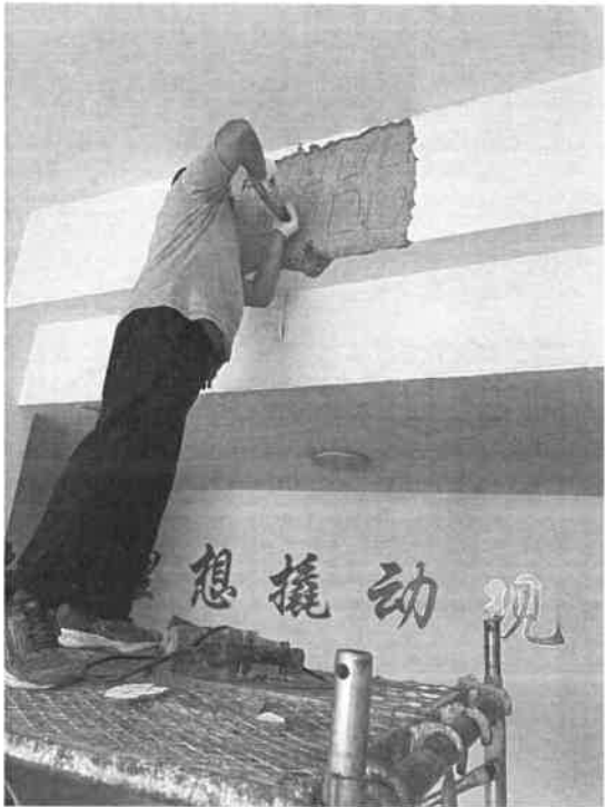
现场检测照片
