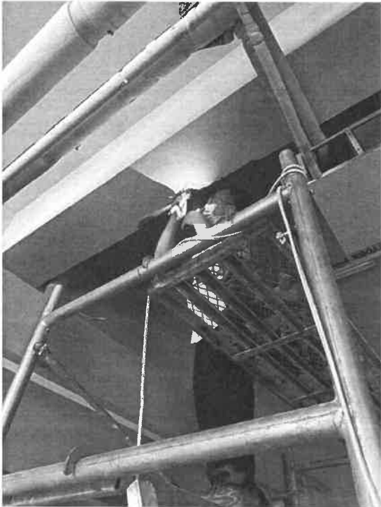
现场检测照片
